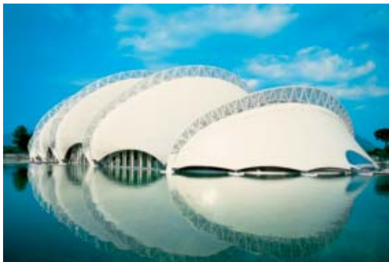
M & G forskningslaboratoriums exteriör, dagtid.
